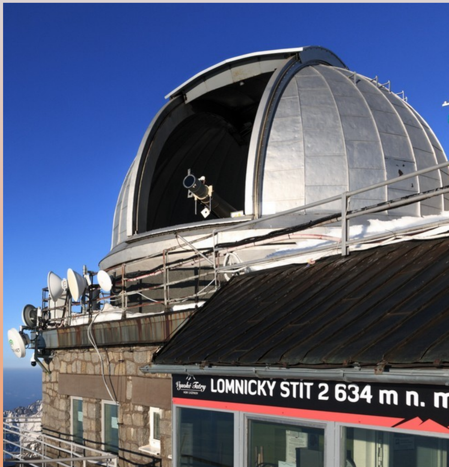
Kupola observatória Lomnický štít s dvoma koronografmi ZEISS na pozorovanie Slnka
